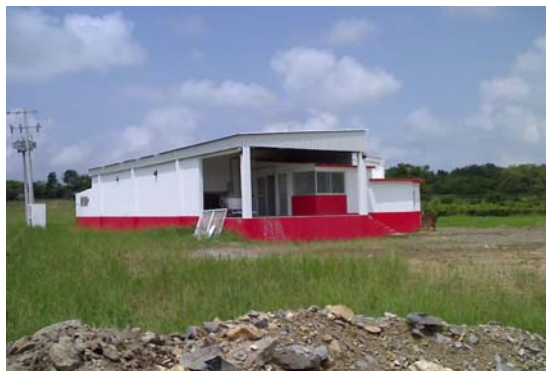
Vista de las instalaciones del Centro de Acopio de Leche en Ozuluama, Veracruz.
